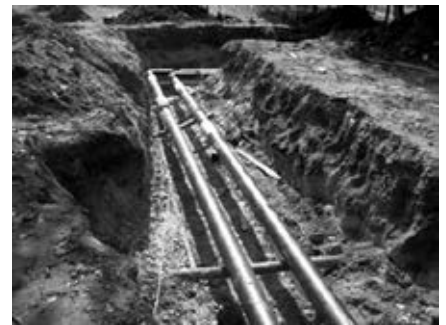
Рис. 148 Безканальне прокладання опалювальних труб
