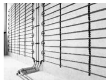
Рис. 135 Укладання полімерної труби на стіну
