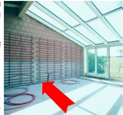
Рис.110 Водяне опалення теплими стінами
