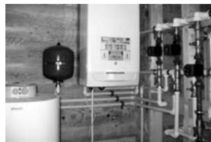
Рис. 157 Обв'язка котла
