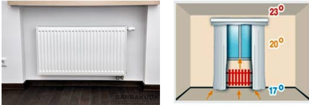
Рис.107 Радіаторні системи водяного опалення
