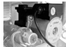
Рис.61 Двоступінчастий циркуляційний насос з ручним перемиканням
