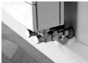
Рис. 151 Декорування трубопроводу опалення коробом
