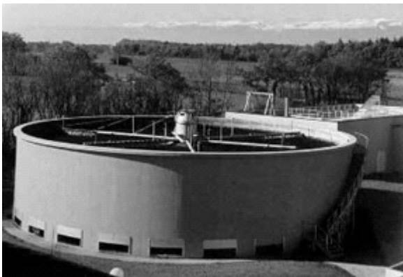
Рис. 6 - Біологічний крапельний фільтр:
