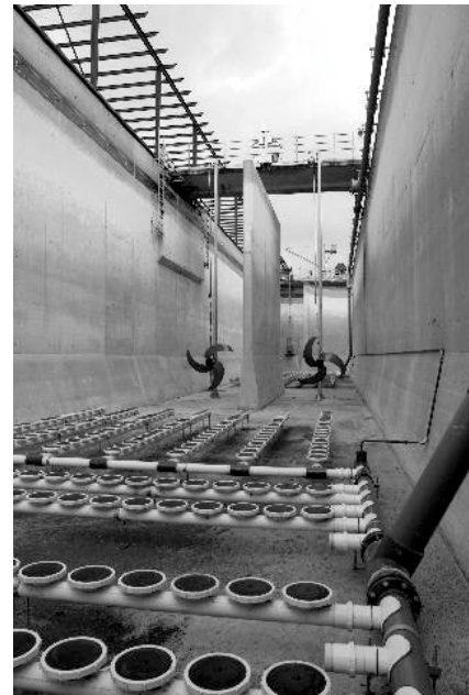
Мішалки та система аерації
