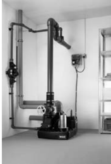
Приклад прокладання трубопроводу вище рівня зворотного підпору
