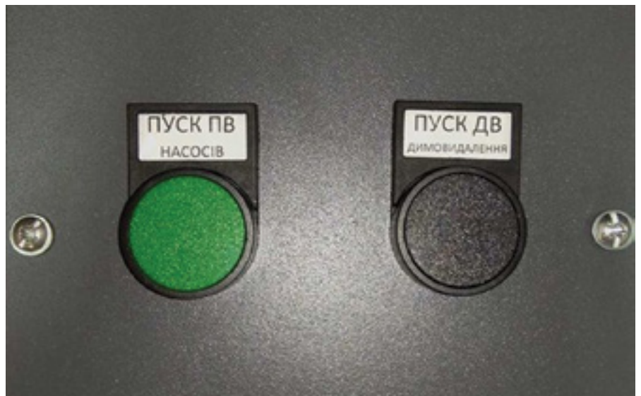
Рис. 2. Загальний вигляд блоку управління в ПК: ПВ – протипожежний водогін, ДВ – димовидалення
