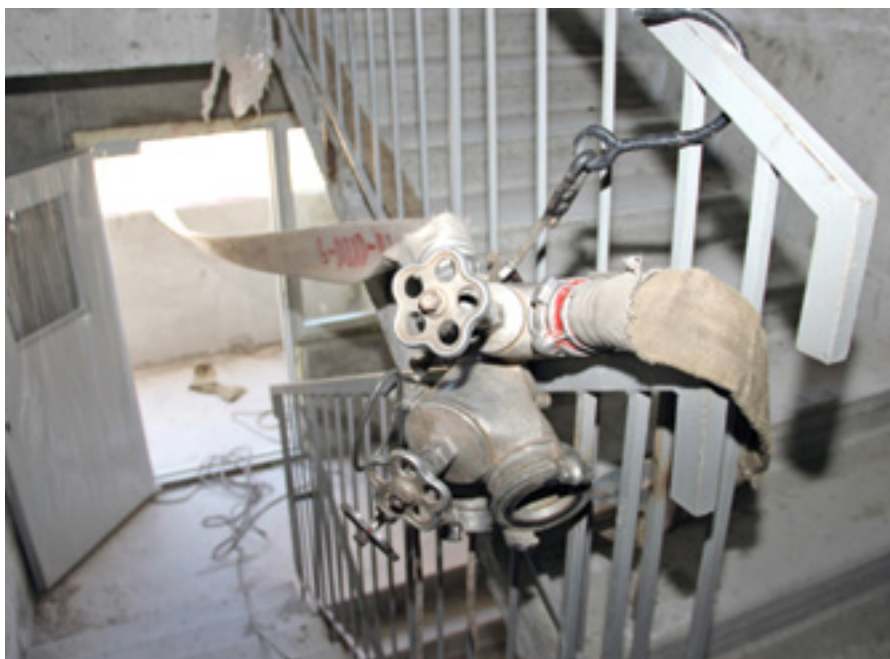
Рис. 1. Оптимальне місце кріплення розгалуження на сходовій клітці
