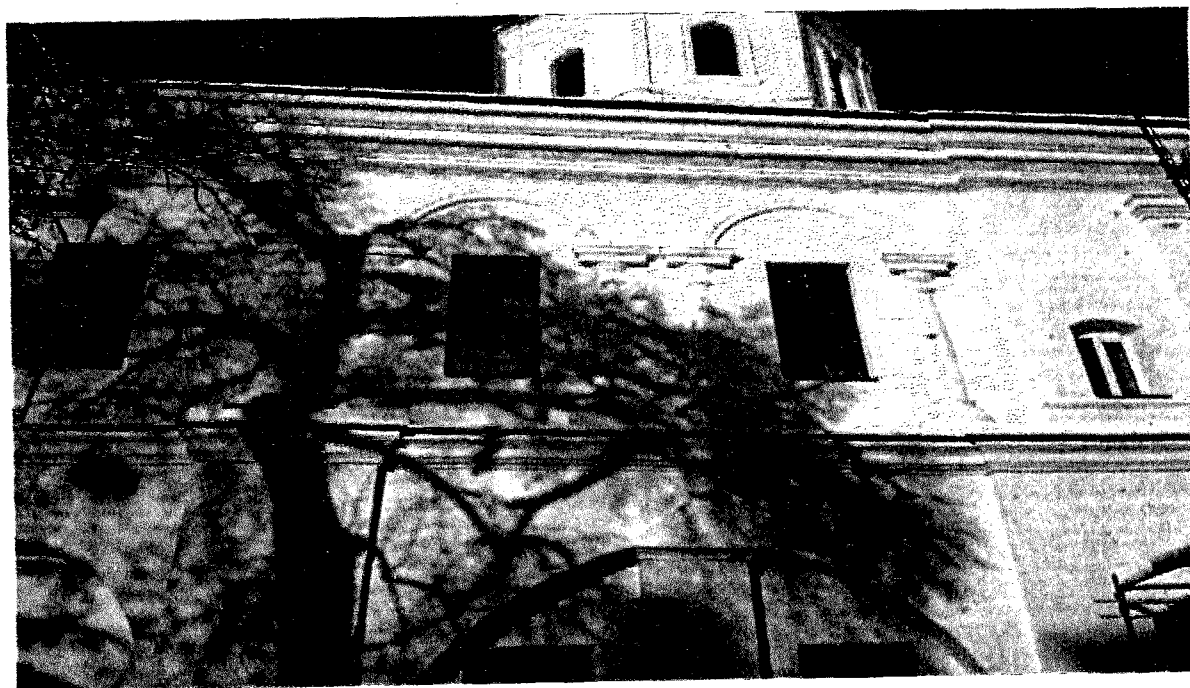
Фото 5,6 . Реставрація фасадів з заміною вікон 2021 р.
