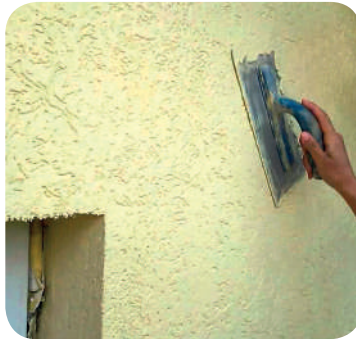
Рис. 9.21. Нанесення штукатурки за допомогою терки
