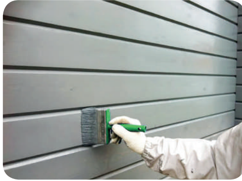
Рис. 8.16. Фарбування дерев'яного фасаду
