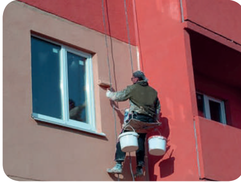
Рис. 8.15. Фарбування фасаду валиком
