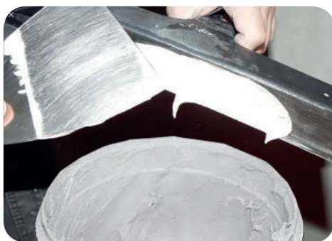
Рис. 7.28. Застосування двох шпательів під час вирівнювання поверхні: а – перенесення шпаклівки з вузького на широкий шпатель; б – розподілення шпаклівки широким шпателем
