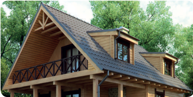
Рис. 8.8. Конструктивний захист деревини
