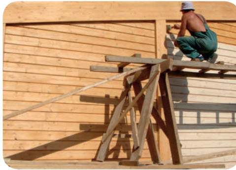
Рис. 8.9. Імпрегнування дерев'яного фасаду
