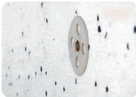
Рис. 9.14. Монтаж кріпильних дюбелів
