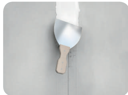
Рис. 7.17. Нанесення шпаклівки на стрічку зі скловолокна
