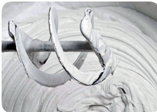
Рис. 7.27. Приготування шпаклівки за допомогою міксера
