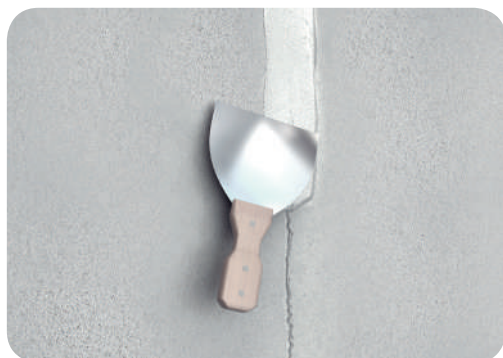
Рис. 7.18. Нанесення шару шпаклівки
