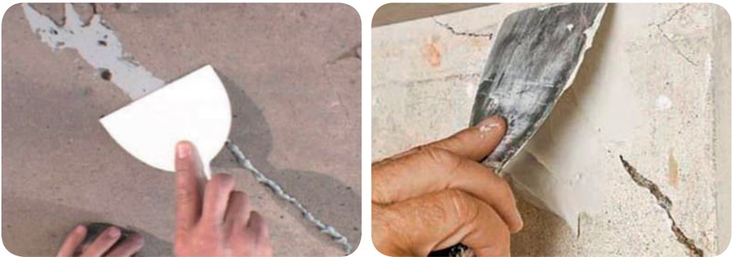
Рис. 8.3. Шпаклювання тріщин на фасаді
