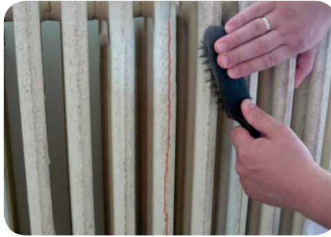
Рис. 7.39. Очищення радіатора опалення за допомогою металевої щітки
