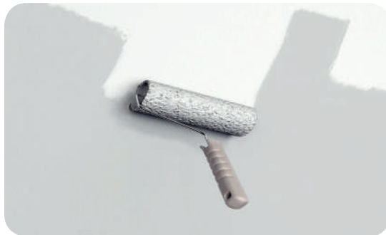
Рис. 7.23. Нанесення ґрунтувальної фарби
