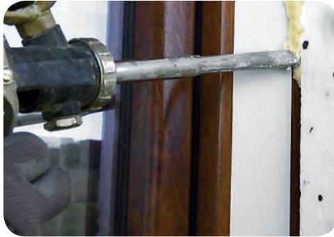
Рис. 9.13. Заповнення щілин між плитами поліуретановою піною
