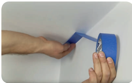
Рис. 7.42. Розмежування поверхонь за допомогою малярної стрічки
