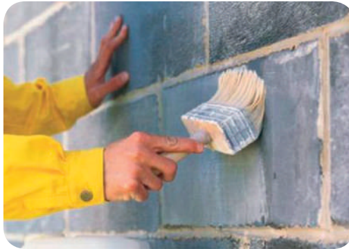
Рис. 8.2. Ґрунтування поверхні фасаду
