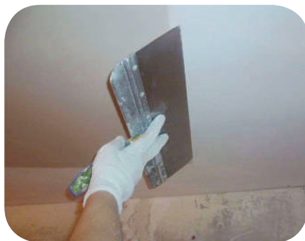
Рис. 7.29. Фінішне шпаклювання стелі за допомогою шпателя
