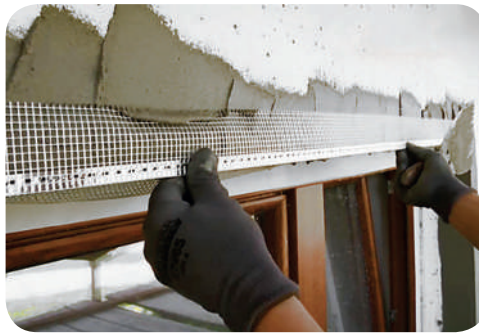
Рис. 9.15. Накладання кутника під армувальну сітку
