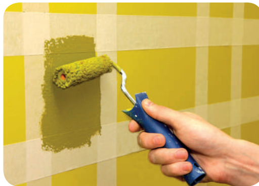
Рис. 7.47. Фарбування із застосуванням малярної стрічки
