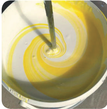
Рис. 8.14. Колорування фасадної фарби
