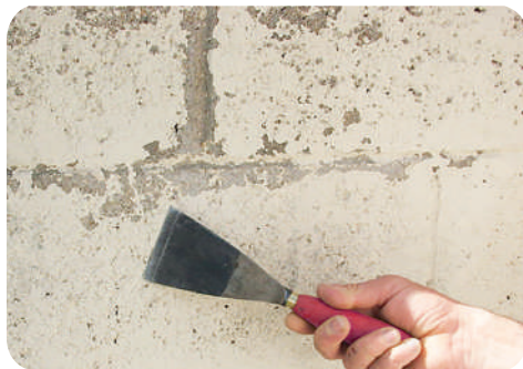
Рис. 8.7. Очищення поверхні фасаду за допомогою шпателя
