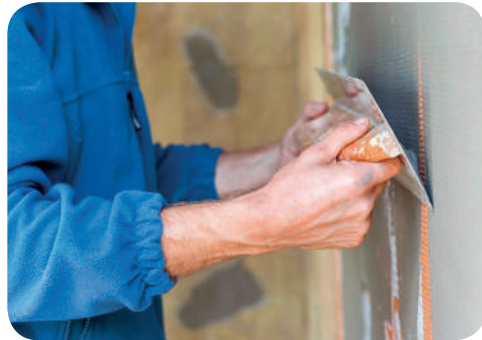
Рис. 9.18. Занурення армувальної сітки у клейовий розчин
