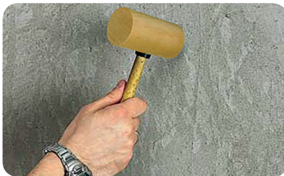
Рис. 8.6. Перевірка штукатурки на наявність відшарування
