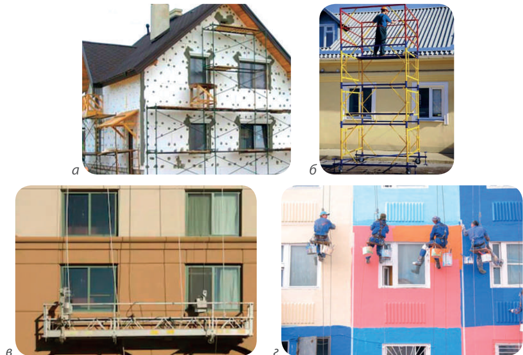
Рис. 8.13. Засоби підмоцвання: а – риштування; б – пересувна вишка; в – коліска будівельна; г – верхолазне спорядження
