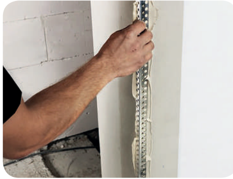
Рис. 7.25. Монтаж алюмінієвого профілю на кут стіни
