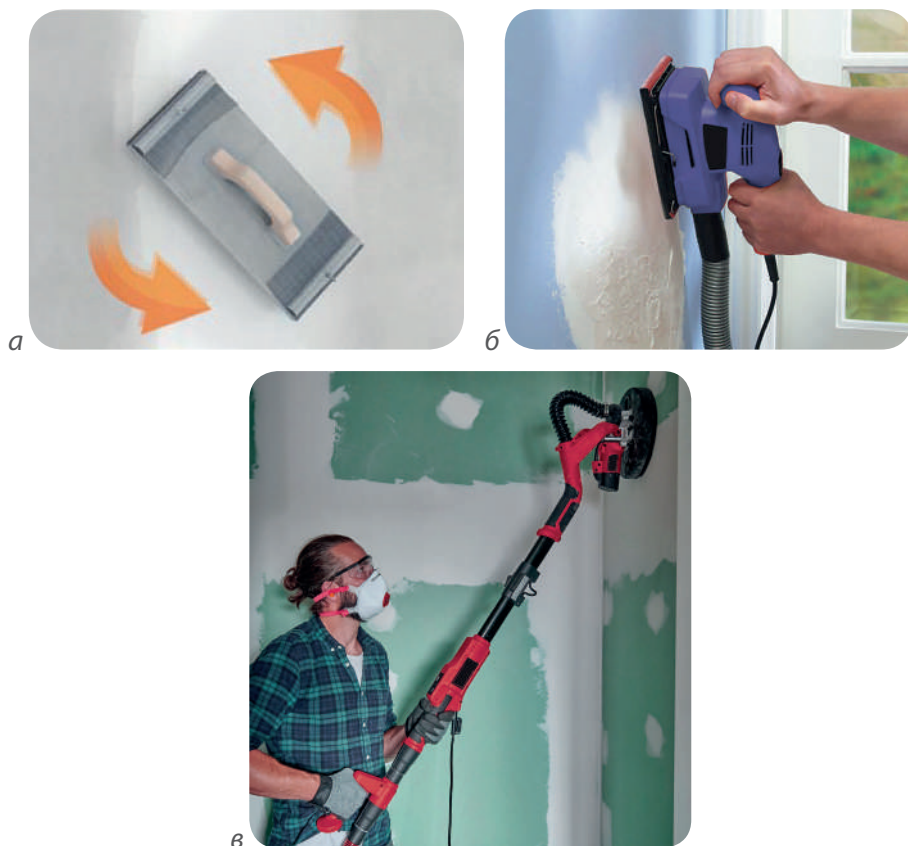
Рис. 7.31. Шліфування нанесеної шпаклювальної маси: а – теркою; б – вібраційною шліфувальною машиною; в – обертовою шліфувальною машиною
