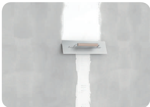
Рис. 7.20. Нанесення шпаклювальної маси на стики плит
