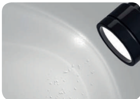
Рис. 7.32. Перевірка якості роботи за допомогою ліхтарика
