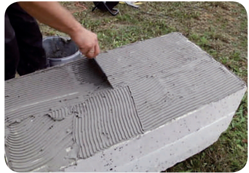
Рис. 9.10. Нанесення клейового розчину суцільним шаром (зубчастою гладилкою)
