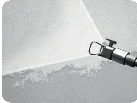
Рис. 7.30. Нанесення фінішної шпаклівки на поверхню стіни машинним способом
