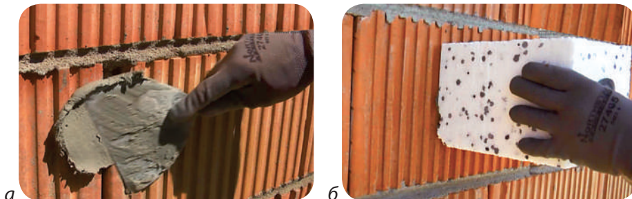
Рис. 9.7. Пробне приклеювання пінополістиролу: а – нанесення клейового розчину; б – притискання зразка пінополістиролу
