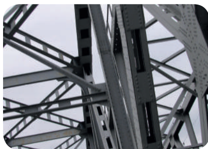
Рис. 5.17. Металева конструкція моста
