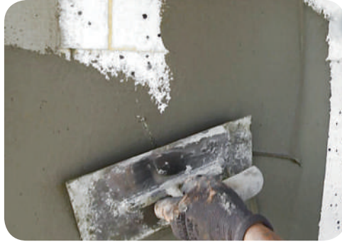
Рис. 9.17. Нанесення клейового розчину
