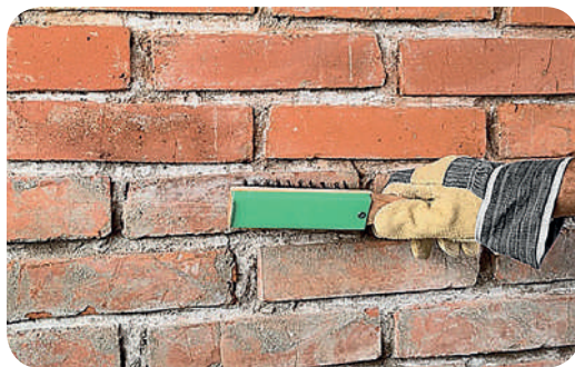
Рис. 7.9. Висоли на цегляній поверхні
