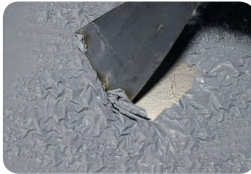
Рис. 7.3. Хімічний спосіб очищення поверхні
