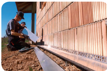
Рис. 9.8. Встановлення цокольного металевого профілю
