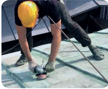
Рис. 8.10. Очищення металевої покрівлі
