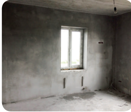
Рис. 7.10. Нова оштукатурена поверхня
