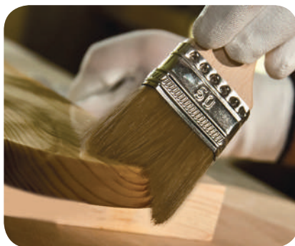
Рис. 7.35. Нанесення ґрунтівки на дерев'яну поверхню
