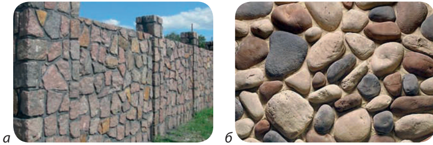
Рис. 5.5. Мурування з бутового каменю (а) і гальки (б)
