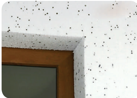
Рис. 9.12. Кріплення теплоізоляційних плит на куті фасадного отвору
