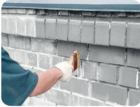
Рис. 8.5. Грунтування силікатної цегли
