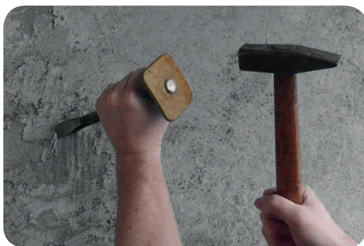
Рис. 8.4. Видалення наплівів з бетонної поверхні
