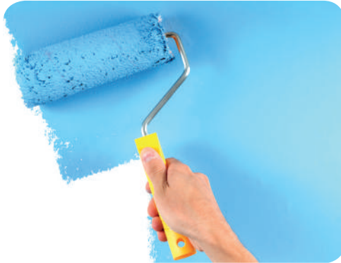
Рис. 1.2. Нанесення фарби малярним валиком
