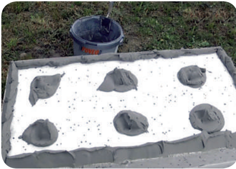
Рис. 9.9. Нанесення клейового розчину «коржичками»
