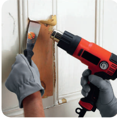
Рис. 7.2. Термічний спосіб очищення поверхні будівельним феном
