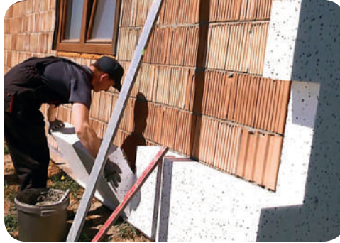
Рис. 9.11. Приклеювання теплоізоляційних плит
