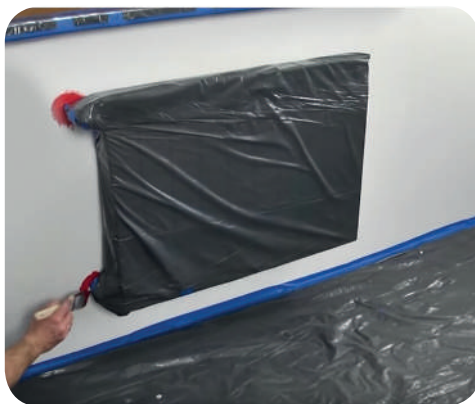
Рис. 7.44. Фарбування важкодоступних місць
