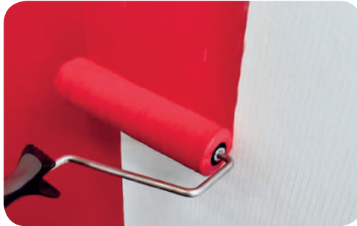
Рис. 7.48. Фарбування шпалер за допомогою валика
