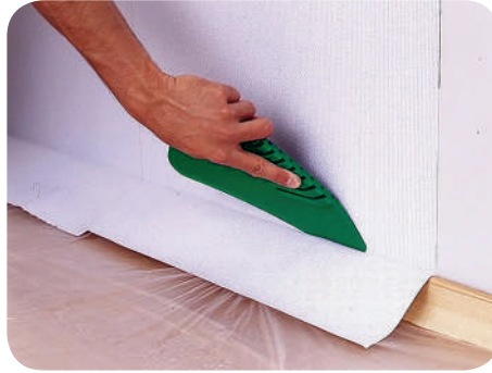
Рис. 7.34. Наклеювання шпалер
