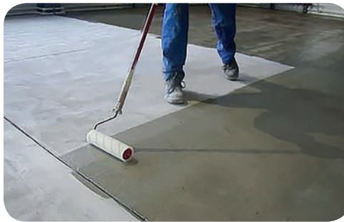
Рис. 7.7. Грунтування бетонної поверхні
