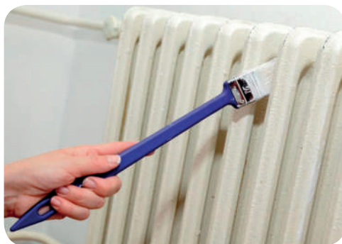
Рис. 7.51. Фарбування радіатора опалення
