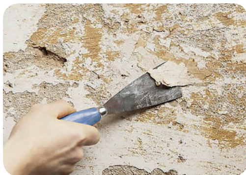
Рис. 7.12. Усунення штукатурного шару, пошкодженого грибком
