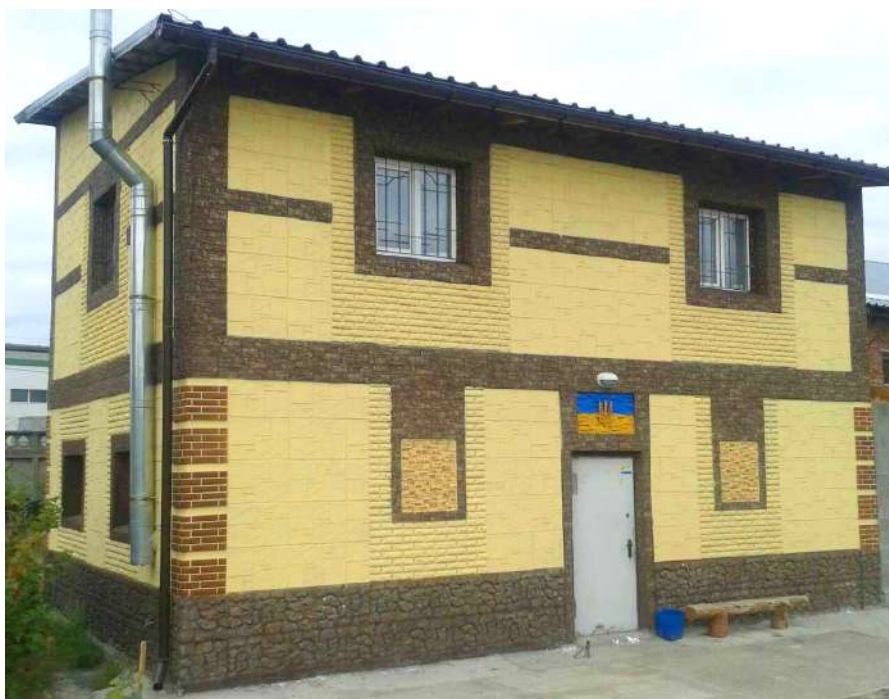
Робота із термомодернізації будівлі із застосуванням системи «Термос»
