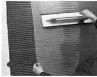
Рисунок 5.15.2 – Втискання склосітки в клейову суміш
