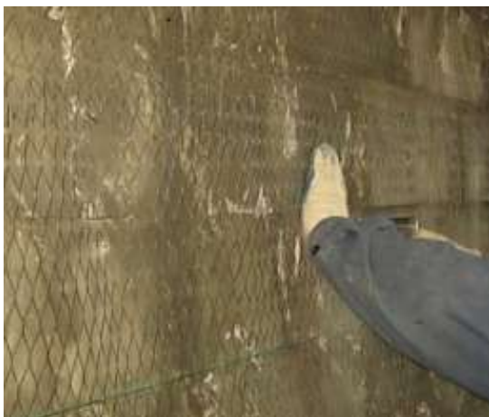
Влаштування базового антивандального штукатурного шару для цокольних і перших поверхів будівель
