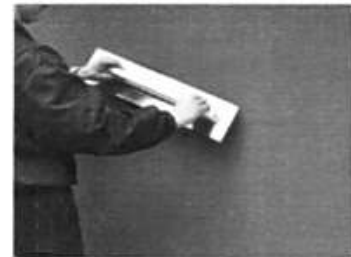
Рисунок 5.15.3 – Вирівнювання базового армованого шару
