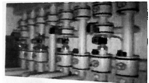
Рис. 82 Монтаж труб з теплоізоляцією
