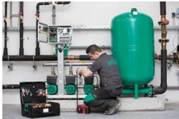
Рис. 58 Монтаж розширювального бака
