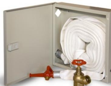
Рис. 68 Внутрішньоквартирна пожежна шафка
