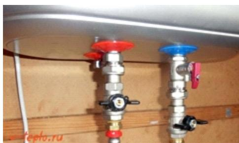
Рис. 104 Схема підключення накопичувального бойлера
